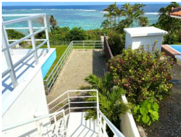
レストランと店舗の 屋上
