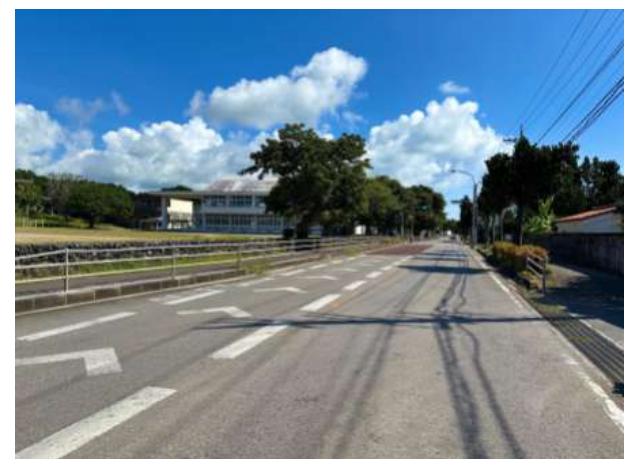
北西側の国道（幅員 9m）
