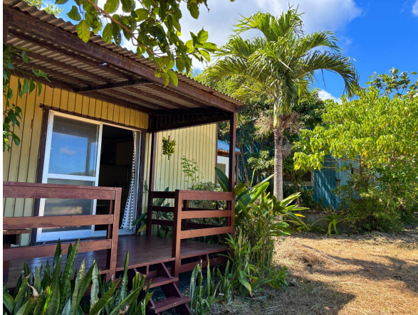
建物ウッドデッキ
